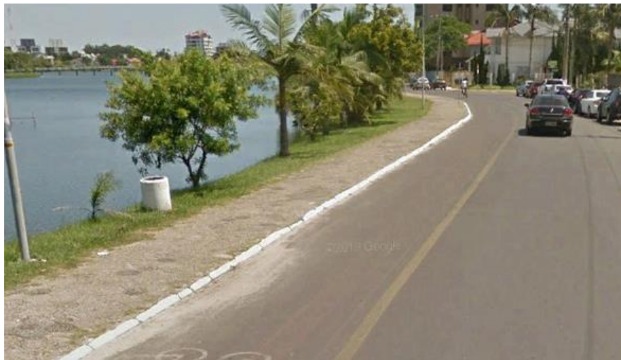
Figura 22 - Calçamento sem acessibilidade
