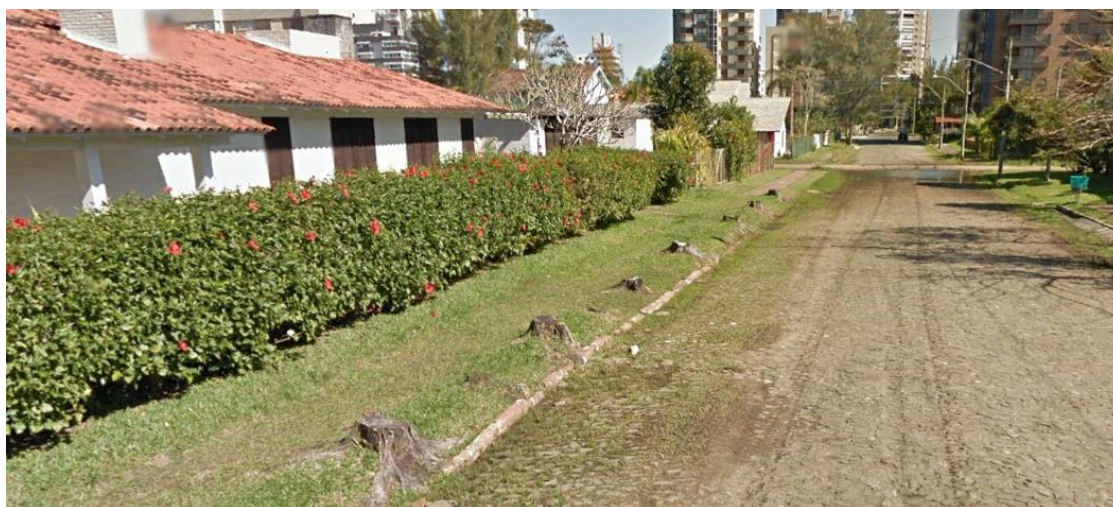
Figura 4 - Calçamento sem acessibilidade
