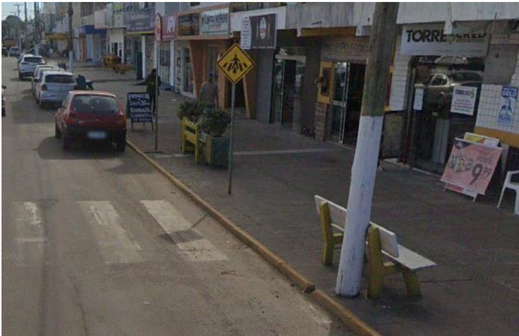
Figura 13 - Calçada sem rebaixo para faixa de pedestre
