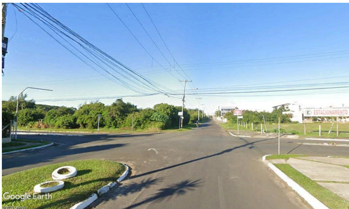
Figura 40 - Falta de sinalização horizontal e vertical.
